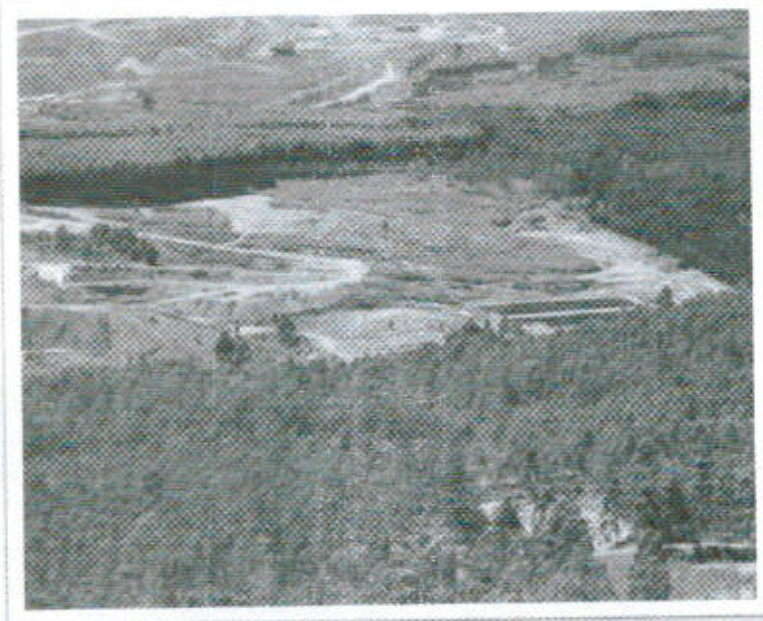
Figura 21 – Vista do aterro sanitário Metade Sul – Candiota/RS
